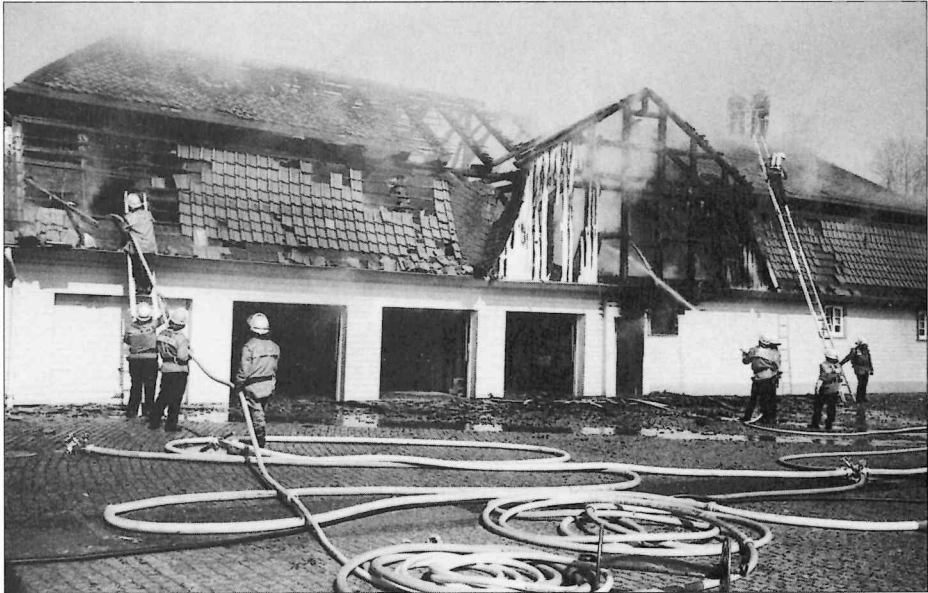
Gebäudebrand „Cramer von Clausbruch“ in der Talstraße, 2. April 1997
