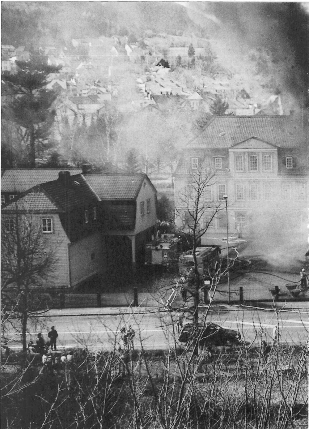
Gebäudebrand „Cramer von Clausbruch“, Talstraße 12, 2. April 1997
