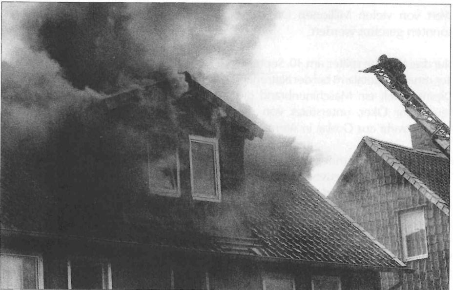
Dachstuhlbrand Kielsche Straße 13, 12. August 1975
